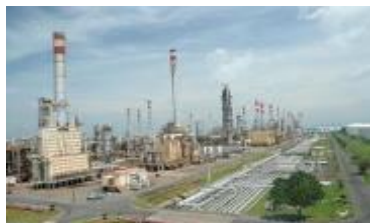
石油精製プラントの運転 制御最適化（横河電機）
