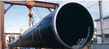
■ 陸上パイプライン
