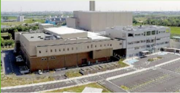
■ シャフト炉式ガス化溶融炉
