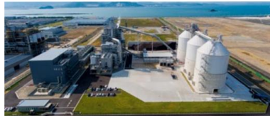
■ バイオマス発電プラント
